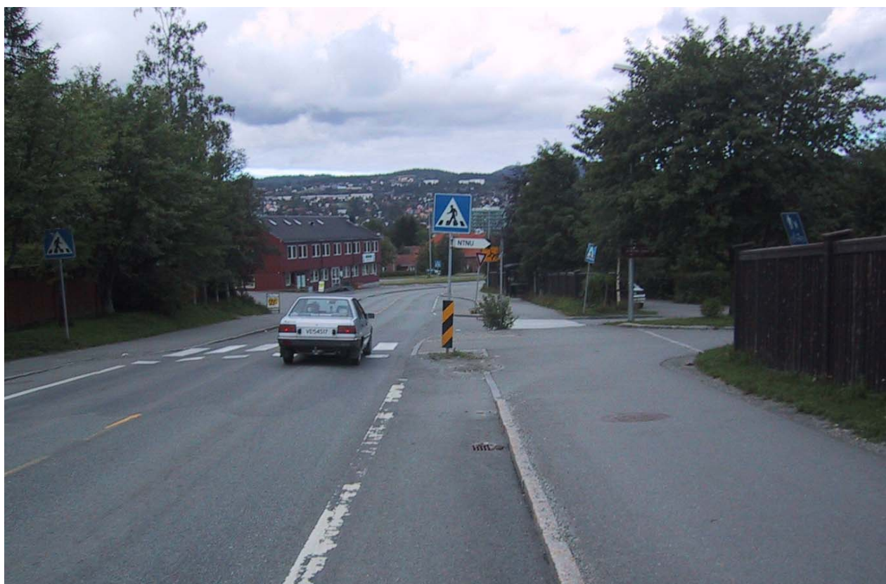
Figur 6: Eksempel på systemskifte. Sykkelfeltet stopper i et gangfelt-skilt. Planleggeren har trolig hatt en idé om at syklistene skal svinge inn til høyre der det er skiltet G/S-veg. Her må syklistene som skal rett frem enten sykle opp på fortauet eller skifte kjørefelt.
